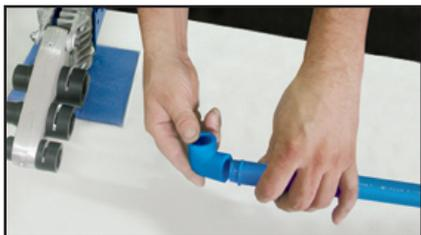
**06** Introduzir o tubo imediatamente na conexão de forma contínua até o batente. Importante: Para as derivações, devem ser observados os pontos de direcionamentos marcados na conexão e no tubo para o correto alinhamento da montagem dos ramais ou derivação;
