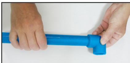
**08** Observar que para uma boa termofusão, deverão se formar dois anéis ao término da união. Deixar esfriar de acordo com a tabela de tempo, sem forçar as partes unidas;
